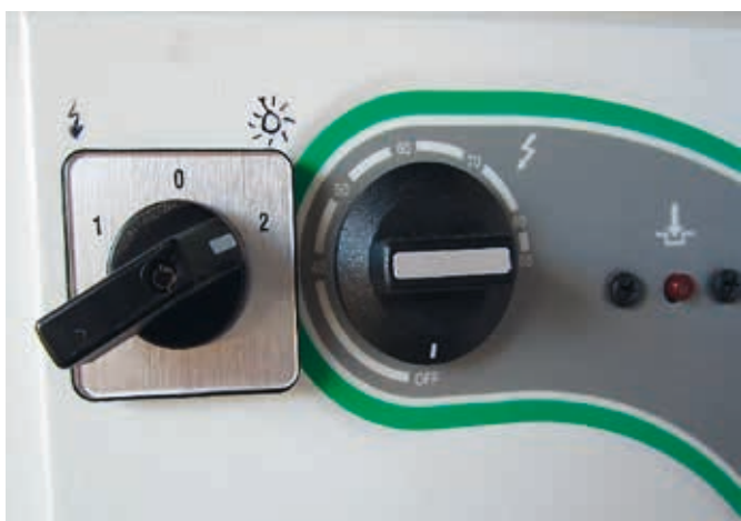
Kuva 8. Vaihtokytkin (Verkko-Pois-Aurinko).
