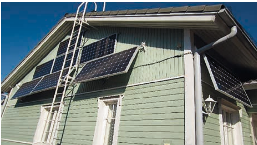
Kuva 5. Eteläseinä (vinssi seinässä palotikkaiden takana).
